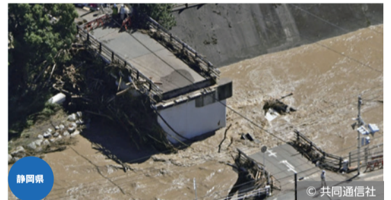
記録的大雨により崩落した二俣川に架かる橋(浜松市)
